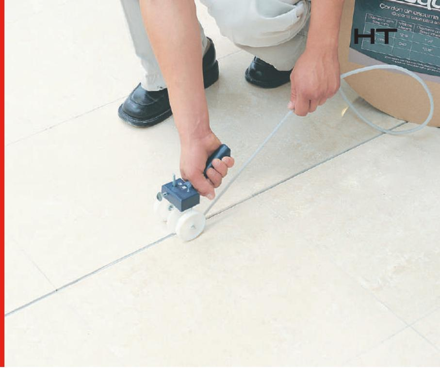
**• Espuma de polietileno de baja densidad • Muy Fácil de aplicar • Especial para juntas de expansión y contracción • Relleno de fisuras**
