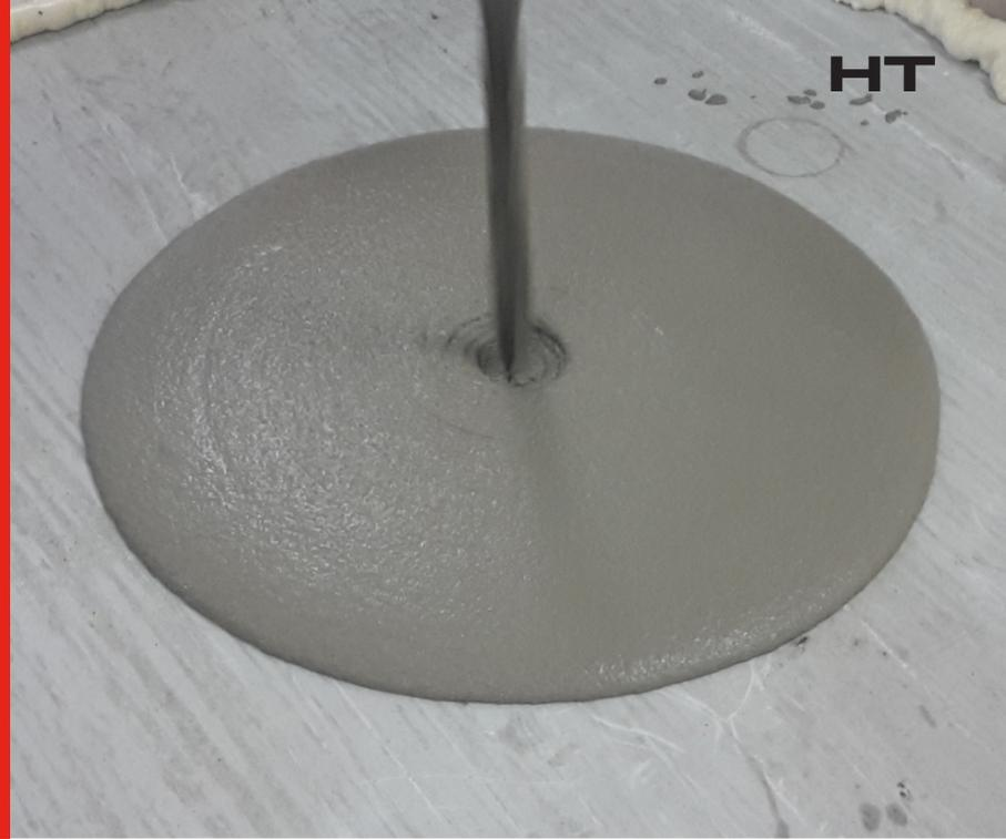
**Nivela espesores de 5 a 25 mm y fragua en 4-5 horas • Alta fluidez, nivela por gravedad evitando el uso de más mano de obra • Mortero líquido de alta resistencia**
