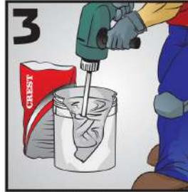
**3** Revuelva bien hasta formar una mezcla homogénea. Deje reposar la mezcla 5 minutos. Para lograr una mezcla homogénea se recomienda un mezclador eléctrico de bajas revoluciones.
