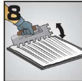
**8** Coloque el adhesivo en la parte posterior de la loseta utilizando la parte plana de la llana sosteniéndola en un ángulo de 60° de la superficie, y después con la sección dentada de la llana inclinada a 60°.
