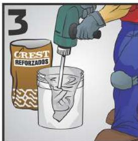
**3** Revuelva bien hasta formar una mezcla homogénea. Deje reposar la mezcla 10 minutos. Para lograr una mezcla homogénea se recomienda un mezclador eléctrico de bajas revoluciones.
