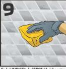
En la LIMPIEZA, la ESPONJA debe estar EXPRIMIDA al 100% (casi seca), trabajando en forma diagonal a las juntas e inspeccio nando el trabajo a medida que va limpiando. La adición de agua durante la limpieza diluirá el producto y causará problemas de curado.
