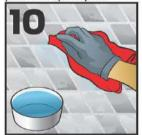
Si es necesaria una segunda limpieza, esperar 3 horas en condiciones de baja humedad / temperatura (550% HR y >21° C) y 6 horas en entornos de alta humedad / temperatura (>50% HR y < 21° C); repitiendo el proceso de limpieza usando una fibra de nylon blanca y húmeda para retirar cualquier resto de boquilla. Cambie el agua de limpieza cada 9 m².
