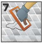
Cuidando que quede bien compacta y libre de espacios vacíos, hendiduras o fisuras. La falta de compresión adecuada puede ocasionar un efecto moteado.
