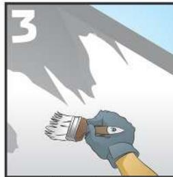
3 Impermeabiliza con ImperCrest Cemento reforzado o Crest Membrana antifractura 2010.
