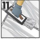
Una vez terminada la instalación, será necesario esperar 24 horas para juntear ("lecherear") o emboquillar. Para juntas menores a 3 mm. Utilizar JuntaCrest Ultramax, junteador sin arena silica y para juntas mayores a 3 mm. Utilizar BoquiCrest Ultramax emboquillador con arena silica.
