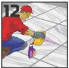
Limpie los residuos de adhesivo una vez terminada la instalación con una esponja o trapo húmedo. Es necesario esperar 24 horas para transitarla.
