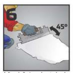
Aplique el adhesivo con la parte plana de la llana, sosteniéndola en un ángulo de 45º de la superficie. Aplique solo el adhesivo que puede ser usado en los próximos 45 minutos.
