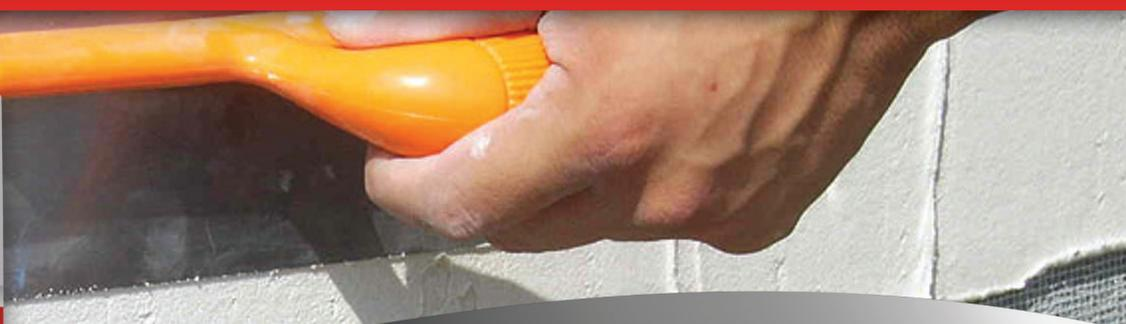
Es un adhesivo en polvo, base cemento con resinas especiales para adherir poliestireno, aditivos químicos y agregados petreos de granulometría controlada. Al ser mezclado con agua se convierte en una pasta especial para instalar poliestireno sobre sustratos porosos, brindando excelente adherencia.
